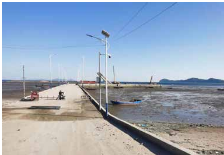
图 2-3 码头现状照片
