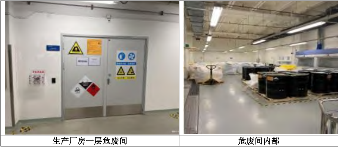
图 2-4 现有工程危废暂存间照片
