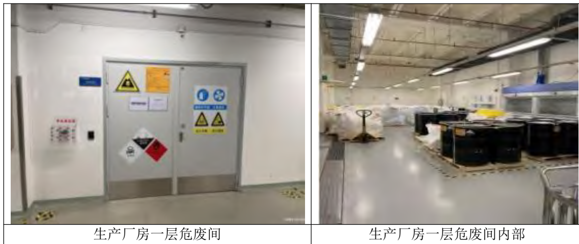
图 2-20 现有工程危废暂存间设施图
