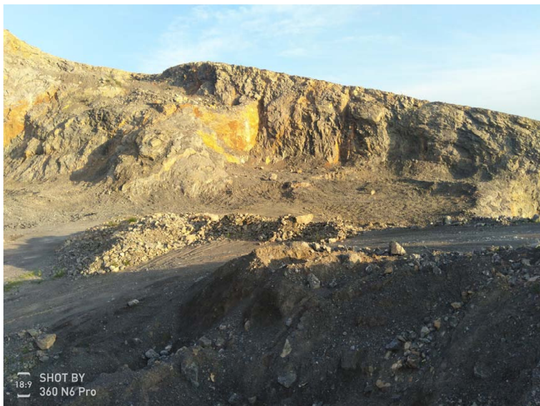
照片 1 矿区开采现状
