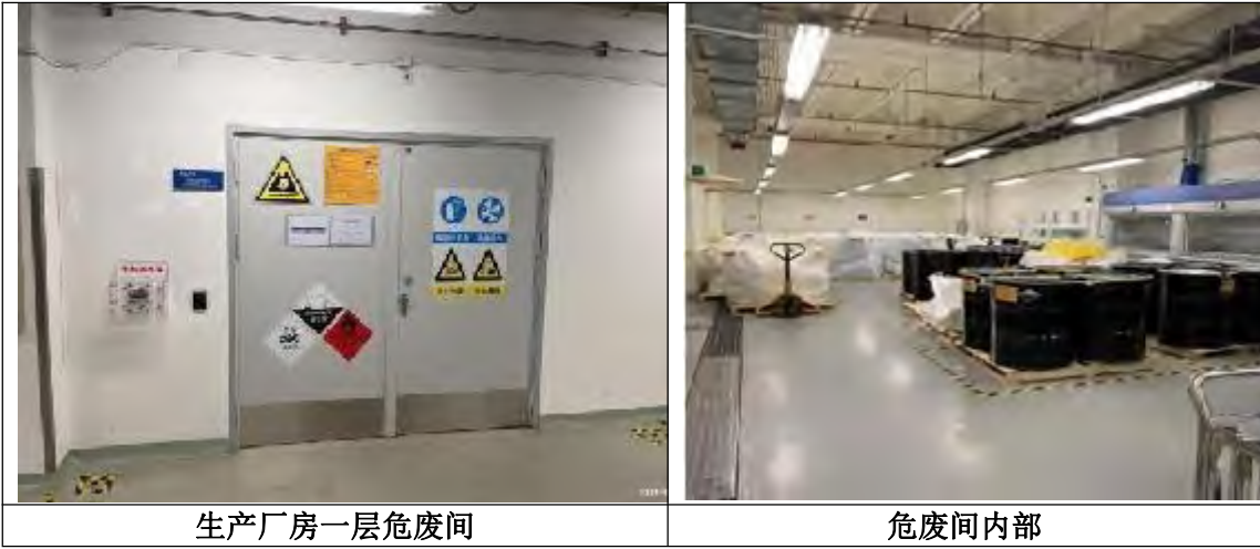
图 2-4 现有工程危废暂存间照片
