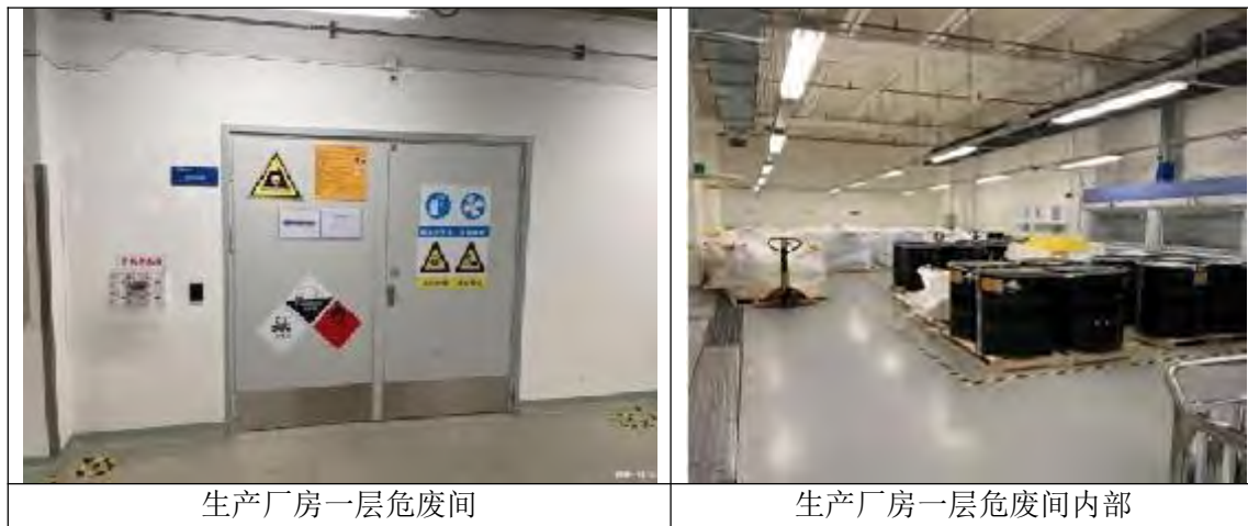
图 2-20 现有工程危废暂存间设施图
