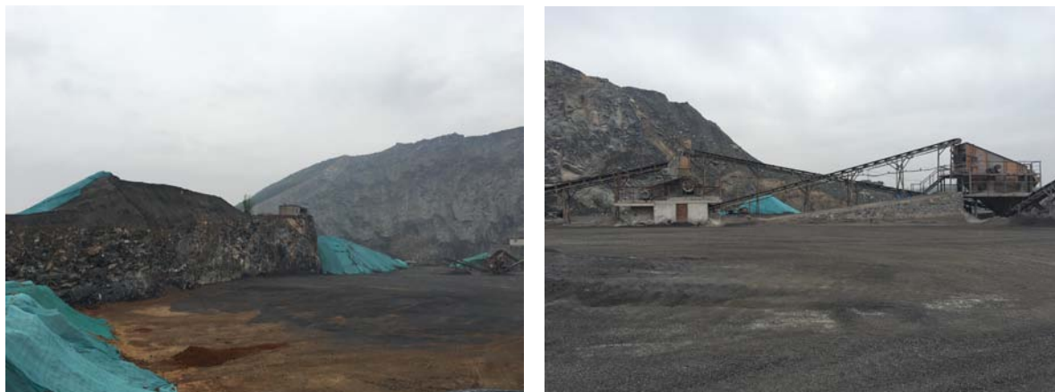
图 1： 现场勘查照片
